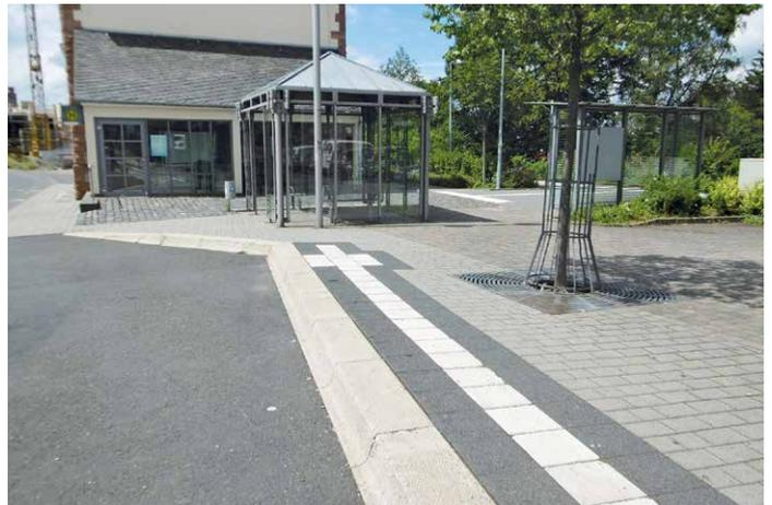
In die Regio-Shuttles kann stufenfrei eingestiegen werden. Die Busbuchten vor dem Bahnhof sind mit dem Kasseler Sonderbord ausgestattet.
